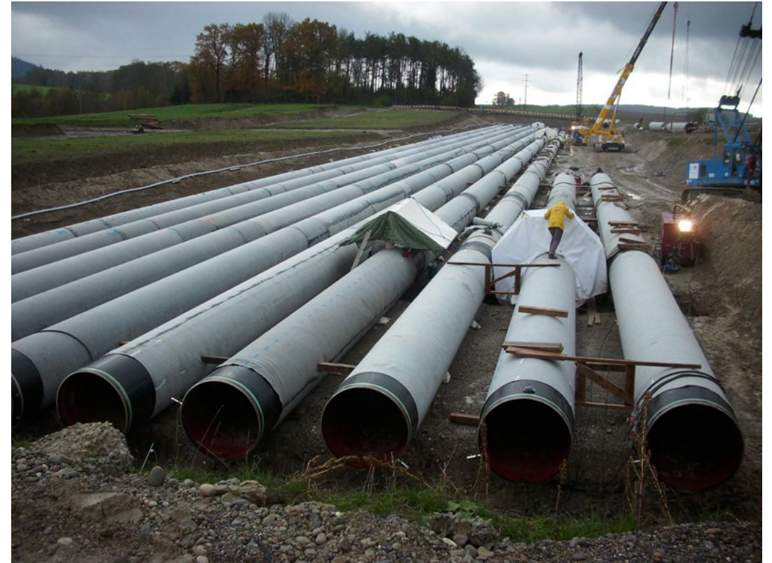
Réservoir tubulaire de gaz naturel à Urdorf
