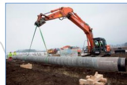
Construction et entretien de gazoducs haute pression
