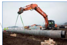
Bau und Instandhaltung von Hochdruckgasleitungen
