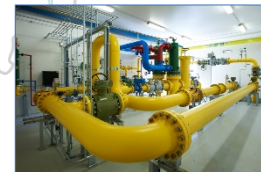
Bau von Verbindungs- und Entspannungsstationen
