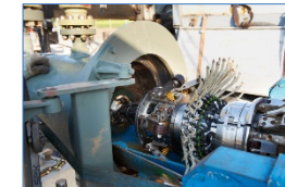
Überprüfung der Integrität von Leitungen
