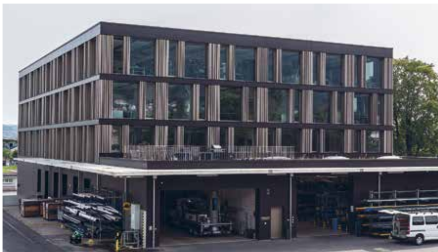
Le bâtiment de la SWG est considéré comme un modèle d'une alimentation énergétique durable. Photo: SWG
