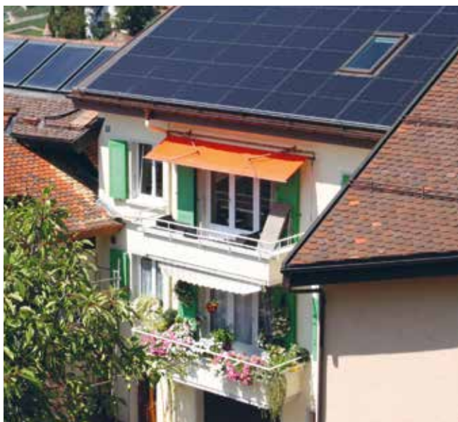
Das Mehrfamilienhaus in Yvorne. Rechts, mit liegendem Dachfenster, die PV-Anlage, links die thermische Solaranlage mit einer Fläche von 9 m 2 .
