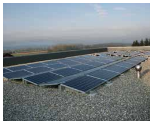
L'installation photovoltaïque de 190 m 2 .
